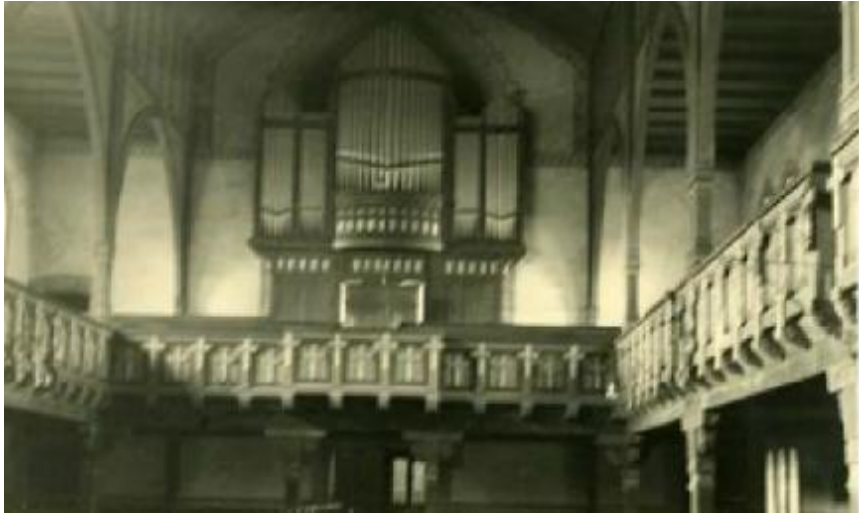
(Emporenbrüstung mit den Holzkreuzen)
